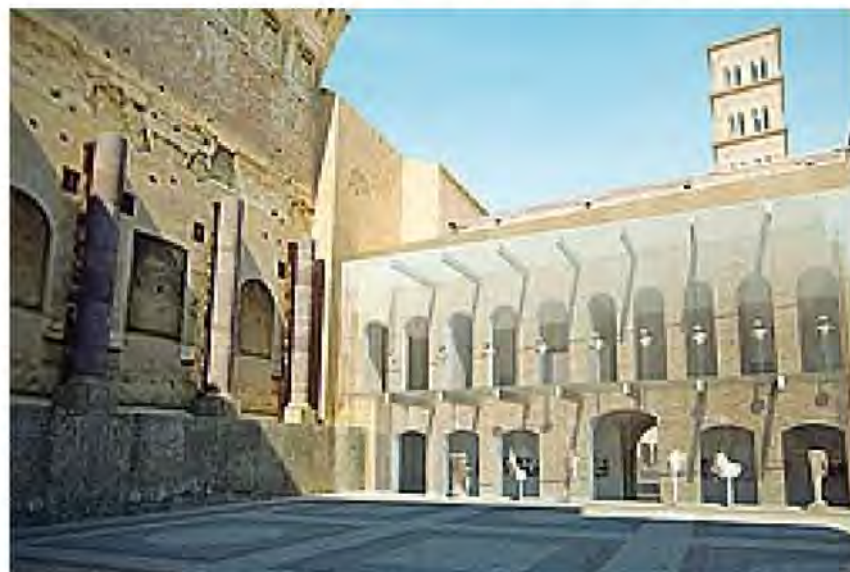
Qui sopra il progetto del nuovo Foro Antiquarium di Roma (foto Bellini). In alto il Mico, Centro congressi di Milano al Portello (foto Raffaele Cipolletta)
